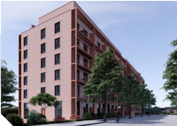
▲ Eckelmans Erasme Campus II, Anderlecht TYPE DE PROJET 68 flats + 144 kots pour étudiants ARCHITECTE A2RC
