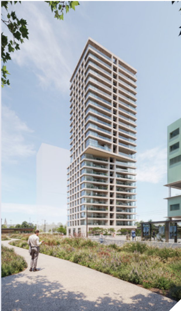
▲ IMMPACT (en collaboration avec Groep Versluys) Twist Tower, Anvers TYPE DE PROJET Résidentiel ARCHITECTE BINST Architects + KAAAN Architecten
