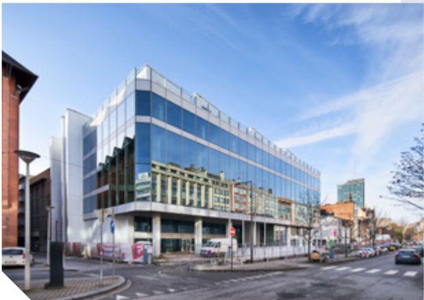
▲ Thomas & Piron Bâtiment Solidaris, Charleroi TYPE DE PROJET Bureaux ARCHITECTE Atelier de l'Arbre d'Or
