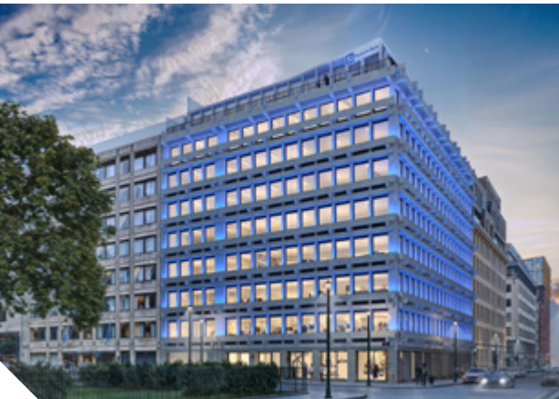
Burco Europe Meeus 29, Bruxelles TYPE DE PROJET Bureaux ARCHITECTE ARCHI2000
