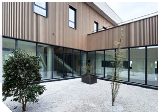
▲ Actibel Centre de Conservation et d'Etudes de l'Agence Wallonne du Patrimoine, Namur TYPE DE PROJET Semi-industriel ARCHITECTE Bureau d'Architecture Emmanuel Bouffioux (BAEB)
