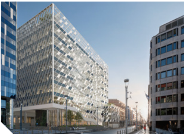
▲ Atenor Realex, Bruxelles TYPE DE PROJET Bureaux et Centre de Conférence ARCHITECTE assar Architecten
