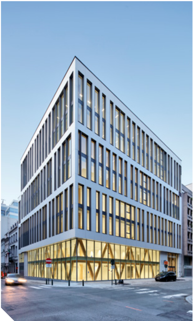
▲ Cofinimmo Montoyer 10 (M10), Bruxelles TYPE DE PROJET Bureaux ARCHITECTE LD2 Architects
