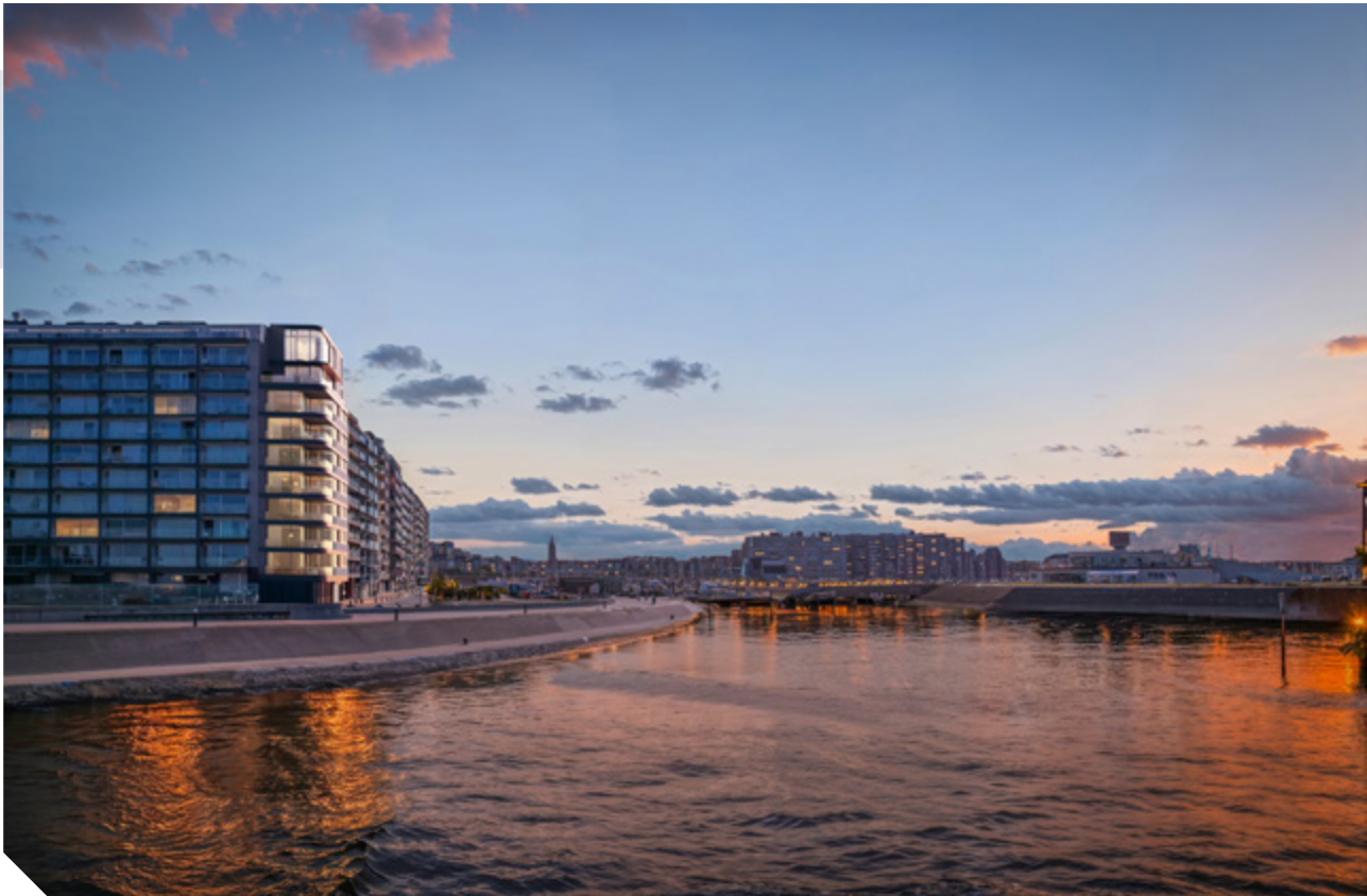
▲ POC Real Estate Blank'O, Blankenberge TYPE DE PROJET Résidentiel ARCHITECTE A1AR Architecten
