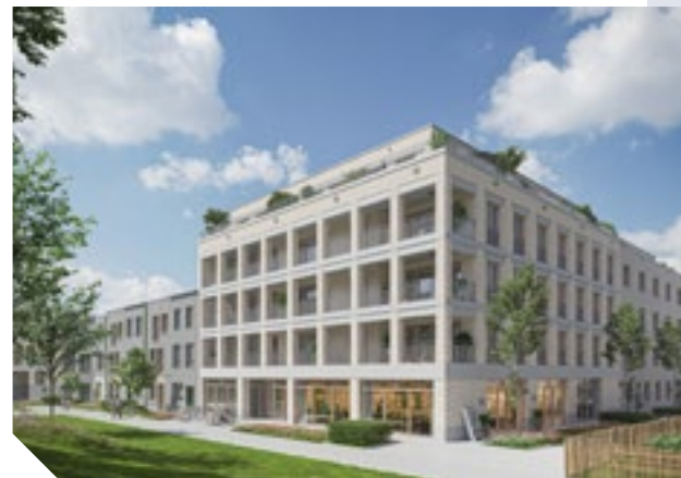
▲ Oryx Projects SA Tondelier - bâtiment Romain, Gand TYPE DE PROJET Résidentiel avec restauration ARCHITECTE Rapp&Rapp
