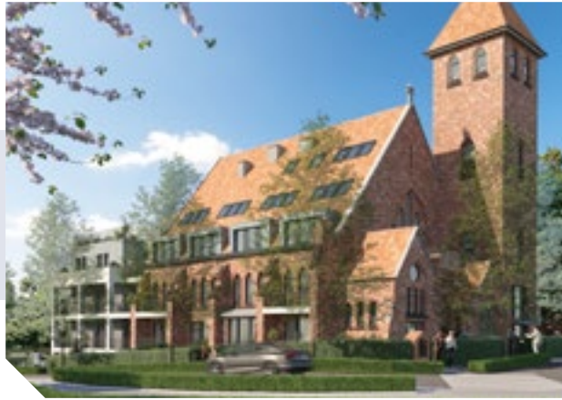
▲ Inside Development Chantecler, Uccle TYPE DE PROJET Reconversion d'une ancienne église en 13 appartements ARCHITECTE Greenarch architecture+environment
