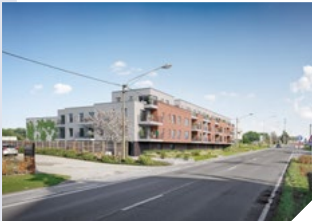
▲ Maisons Blavier SA Résidence "Liberté", Thuin TYPE DE PROJET Résidentiel - immeuble à appartements ARCHITECTE Aas3 sprl (Alain Lust)
