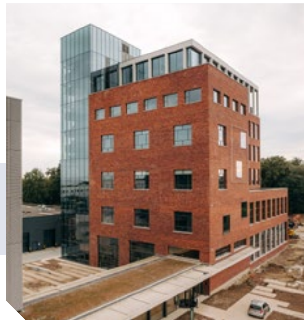
▲ Alinso Group SA Polytoren, Zwijnaarde TYPE DE PROJET Bureaux, event/meetingspace ARCHITECTE POLO Architecture
