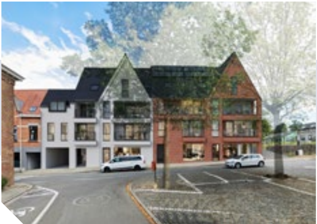
▲ BATO Bouw Projet Louise, Schepdaal
