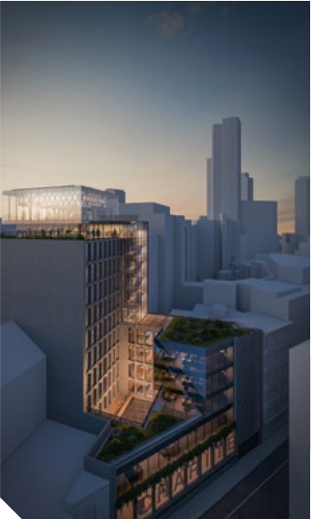
▲ BESIX RED Lighthouse, Saint-Josse TYPE DE PROJET Bureaux ARCHITECTE B2Ai
