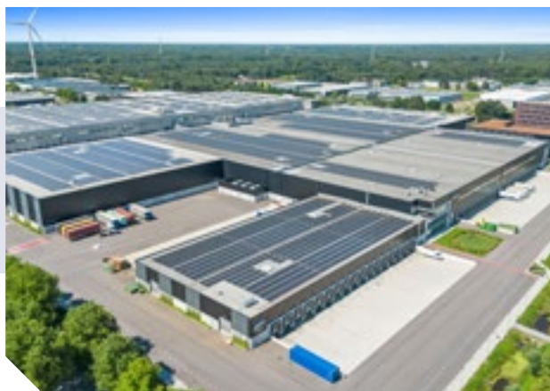
▲ Intervest Herentals Green Logistics, Herentals TYPE DE PROJET Logistique, warehouse ARCHITECTE Frank Joosen
