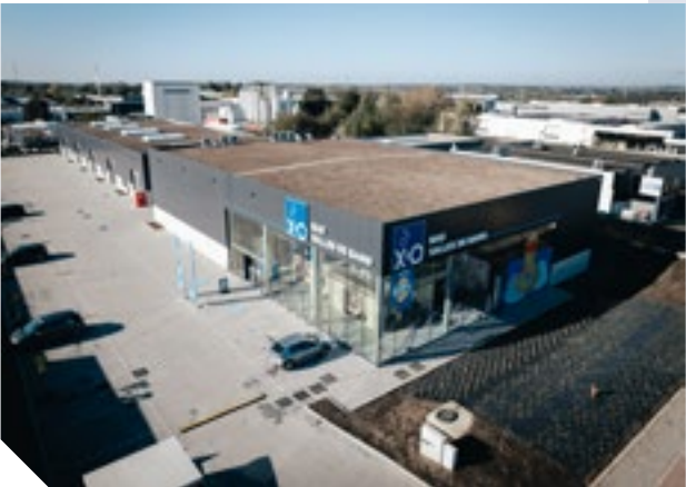
▲ Retail Estates SA Project Eupen, Eupen TYPE DE PROJET Retail ARCHITECTE Borsu Marc Atelier d'Architecture
